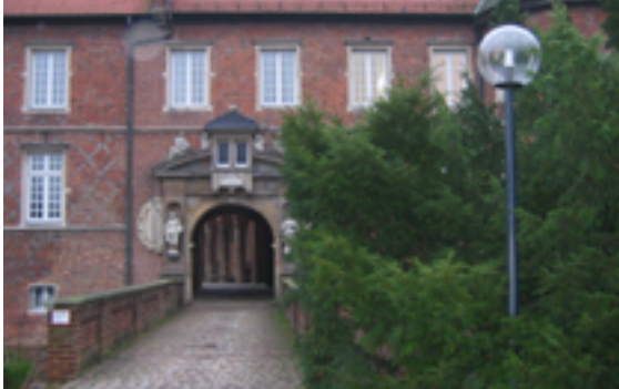
Haupteingang des Wasserschlosses Herten
